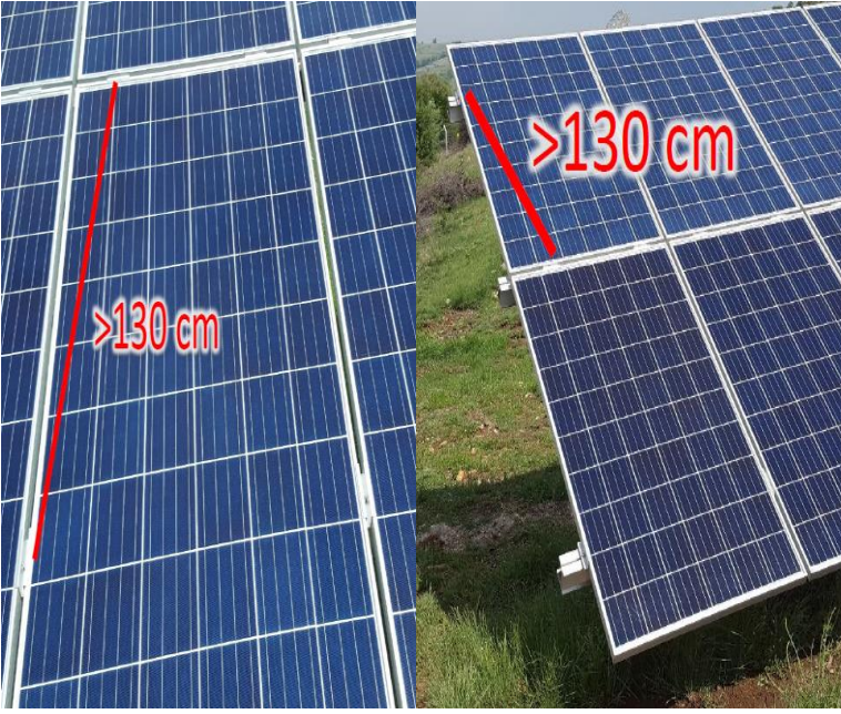
Şekil 11: Sahada kullanılan sehpa montaj sistemine ait mevcut panel tutucular arasındaki mesafe
