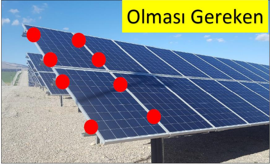
Şekil 10: Sahada kullanılan sehpa montaj sistemine ait olması gereken panel tutucu görünümü
