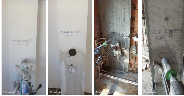
Şekil 2. Karot örneklerinin alınışı ve deliklerin harçla doldurulması
