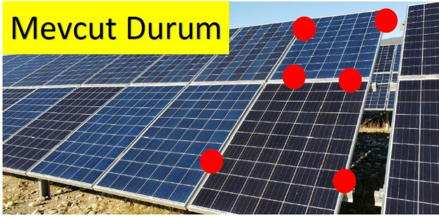
Şekil 9: Sahada kullanılan sehpa montaj sistemine ait mevcut panel tutucu görünümü
