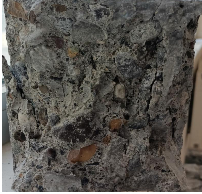
Şekil 1. 4 – Betonun Kırılma Yüzeyi
