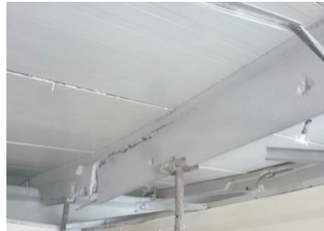
Şekil1. Prefabrike aşık uç hasarı
