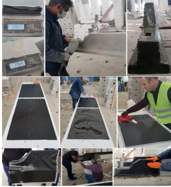
Şekil 3. Kompozit aşıkların oluşturulması
