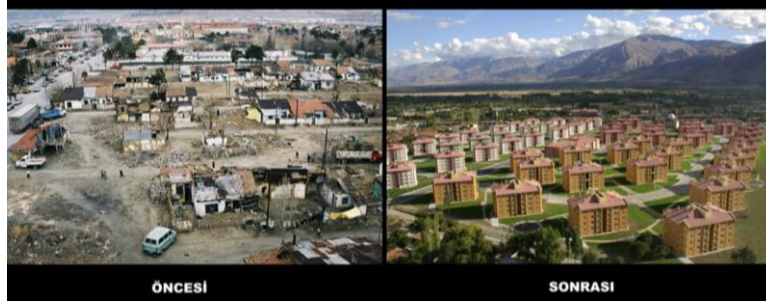
Şekil 9. Erzincan-Merkez'de Gecekondu Dönüşümü (TOKİ, 2021)
